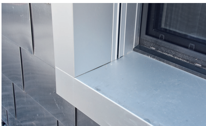
Perfekte An- und Abschlussdetails, Storeschienen in Leibungen integriert, saubere Luftöffnungen unter der Fensterbank, saubere Entwässerung der Leibungen.
