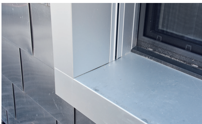
Raccords et finitions parfaits, rails de stores intégrés sur les bords de fenêtres, entrées d'air propre sous les appuis de fenêtres, drainage propre des bords de fenêtres.
